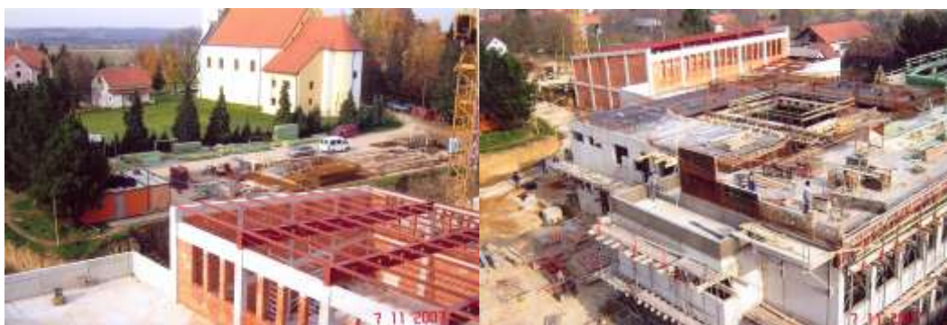
Izgradnja nove škole, 2007.
